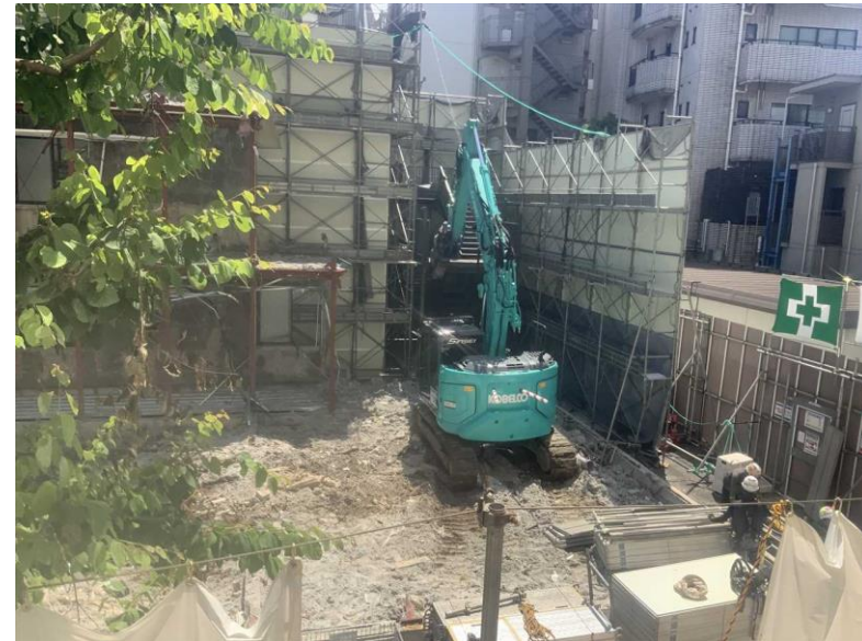
仮設校舎躯体解体
