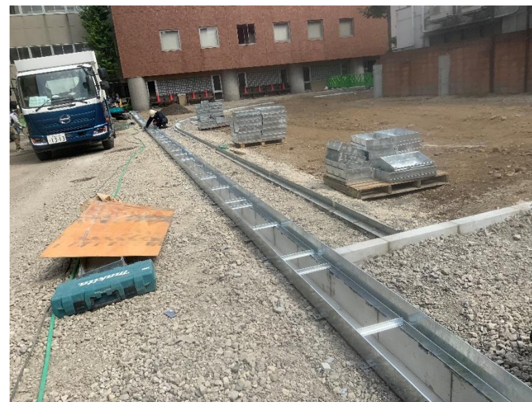
仮設校舎外構枠取付
