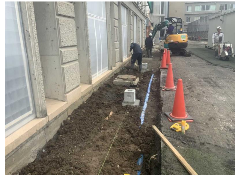
グランド防球ネット設置
