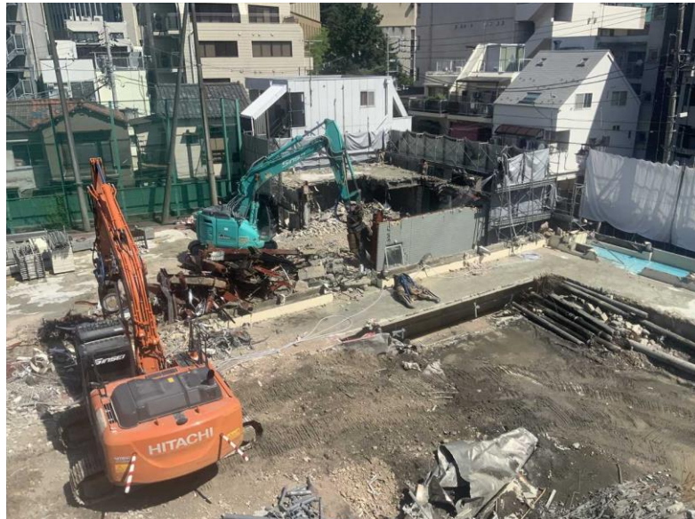
レゾナ棟躯体解体
