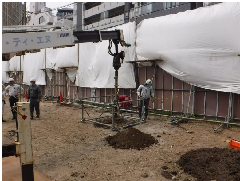
グラウンド北側防球ネット掘削
