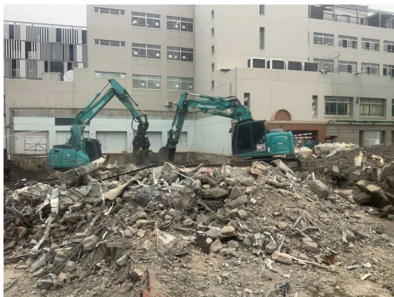
プール棟基礎躯体解体
