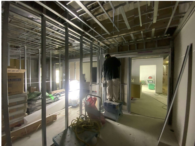
1号館改修工事
