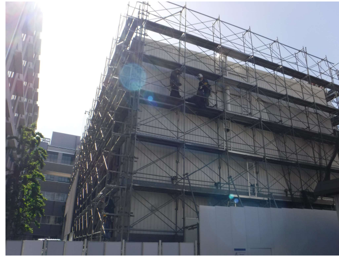
仮設校舎解体工事準備
