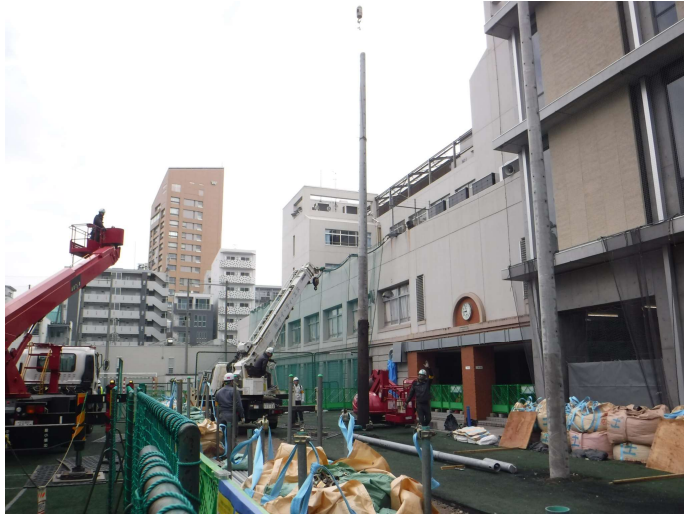
外構（グランド）工事
