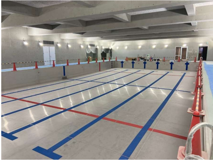
プール施工状況
