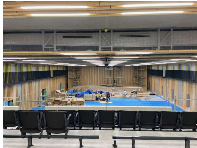
誠ホール施工状況②
