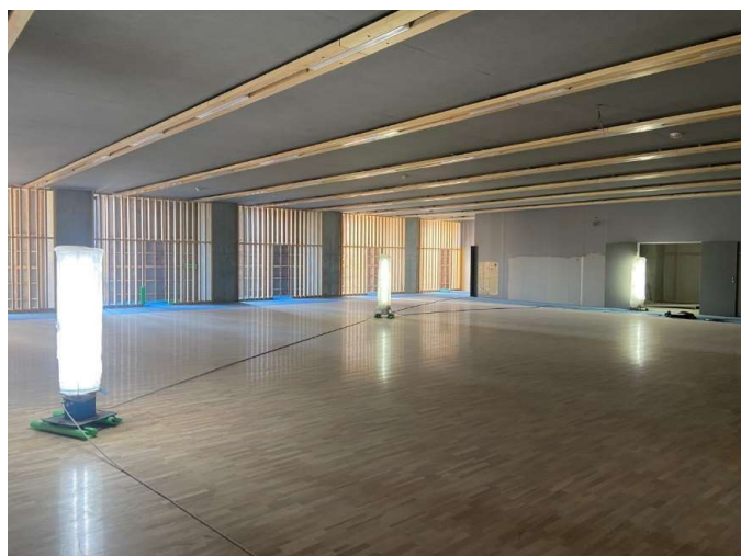
柔剣道場施工状況
