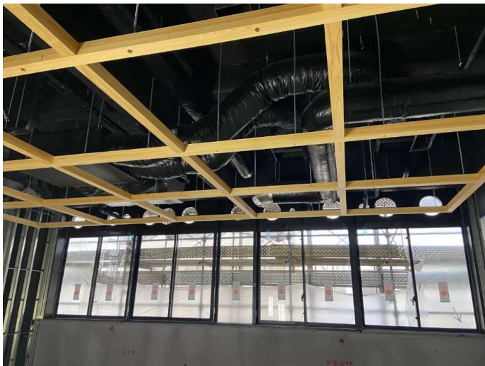
天井施工状況
