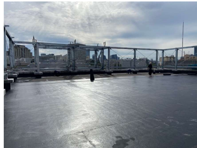
アスファルト防水施工状況
