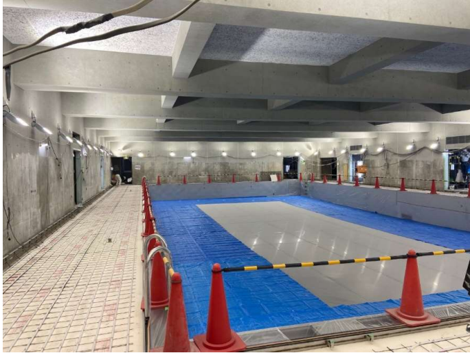
プール施工状況
