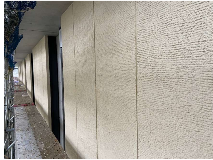
外壁（グランド側）施工状況
