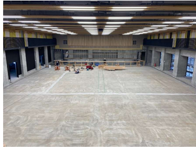
誠ホール施工状況
