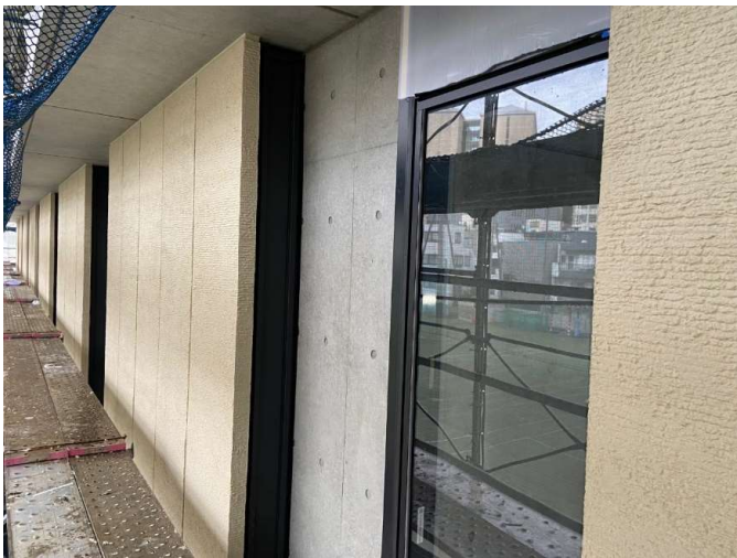
外壁施工（グランド側）状況
