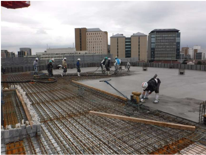
興風館屋上コンクリート打設
