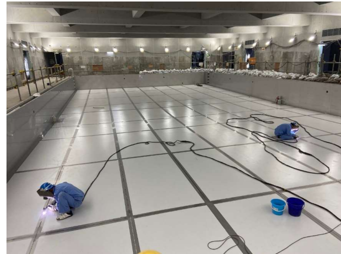
プール施工状況①
