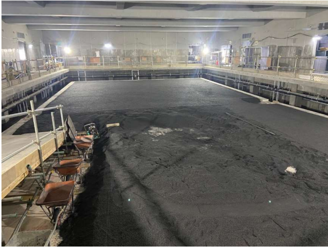
プール施工状況①
