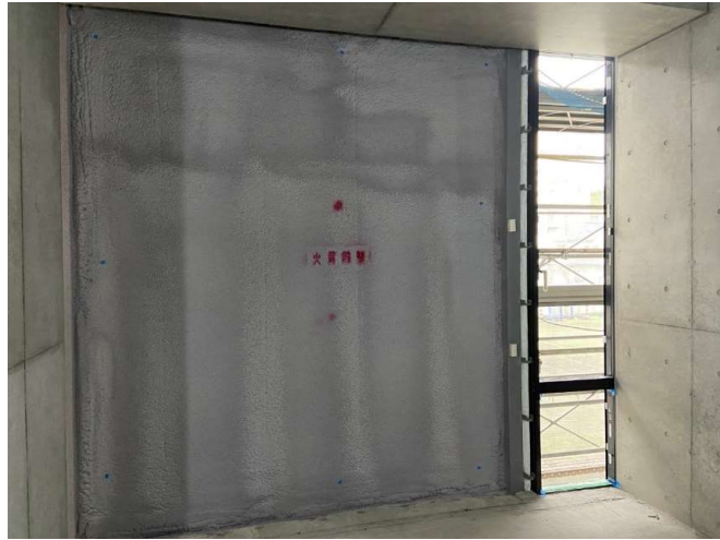
断熱ウレタン施工状況
