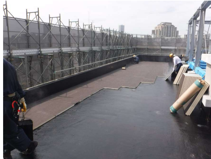
屋上防水工事施工状況
