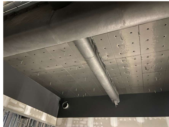
グラスウール施工状況
