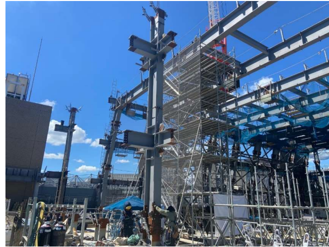
鉄骨建方状況②
