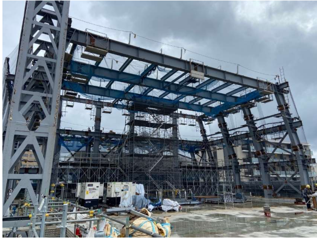
鉄骨建方状況①
