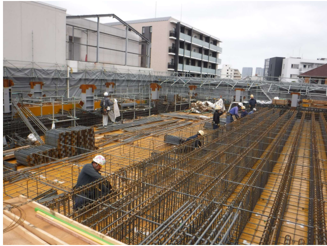
5F床配筋状況
