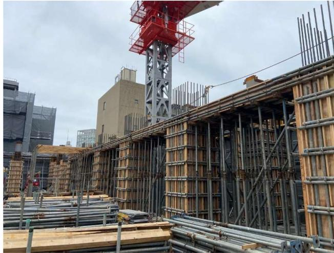
柱型枠組立状況
