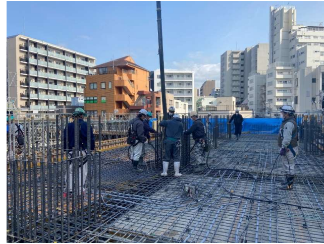
床配筋状況②
