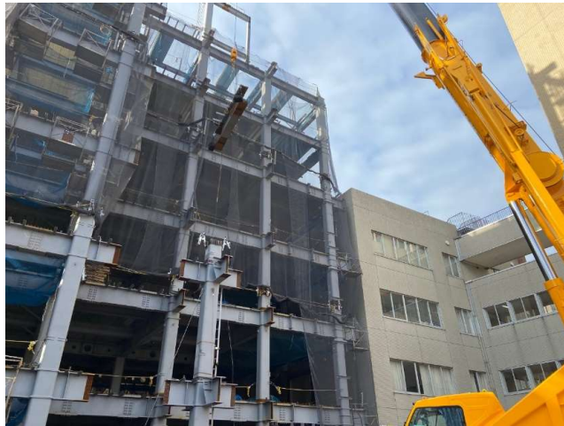
鉄骨建方状況
