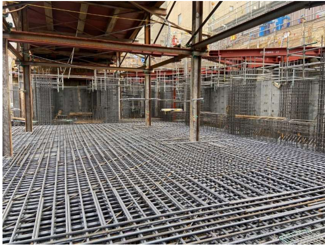
マットスラブ配筋工事
