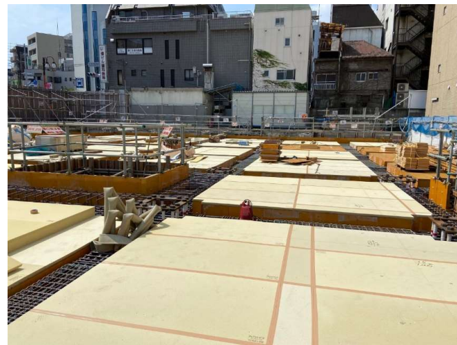
1Fスラブ型枠工事
