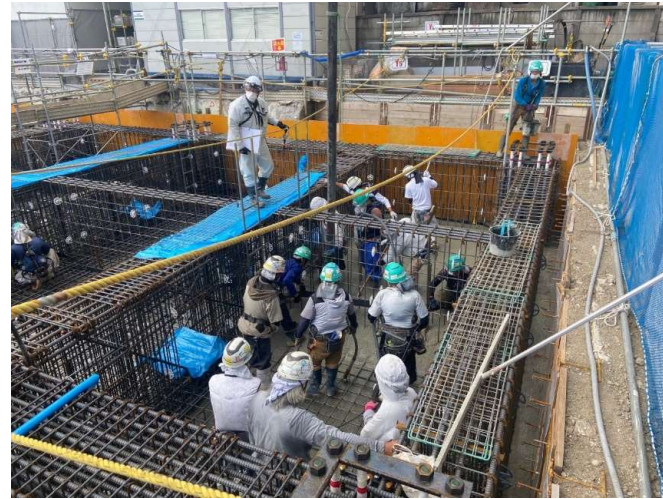
コンクリート打設工事①
