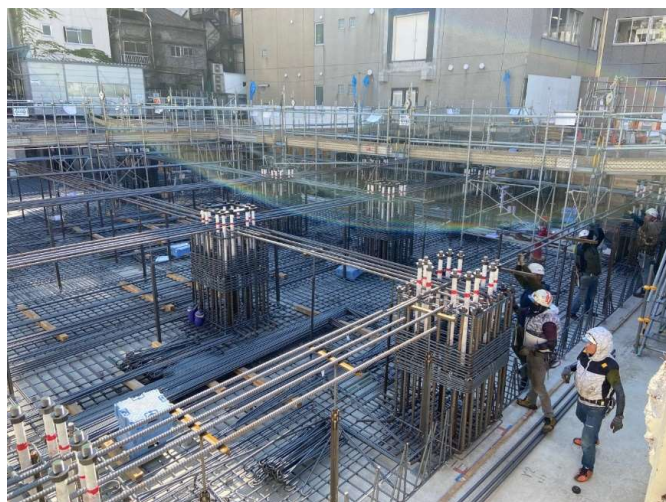
3号館配筋工事
