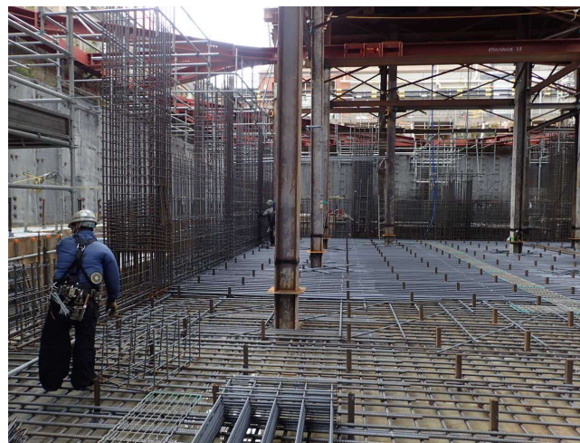
興風館配筋工事
