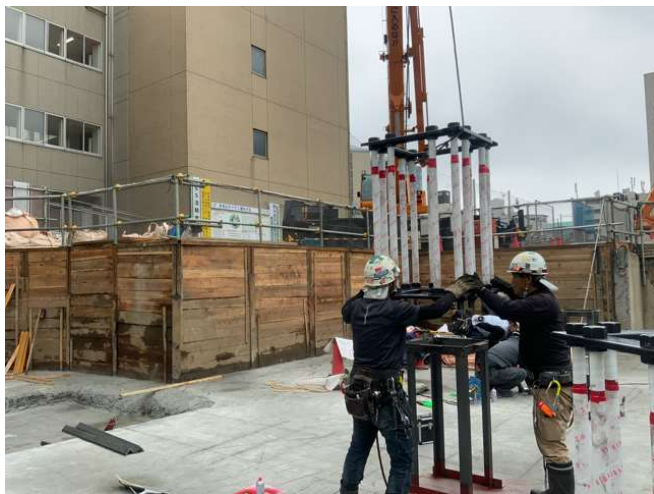
ハイベース設置工事
