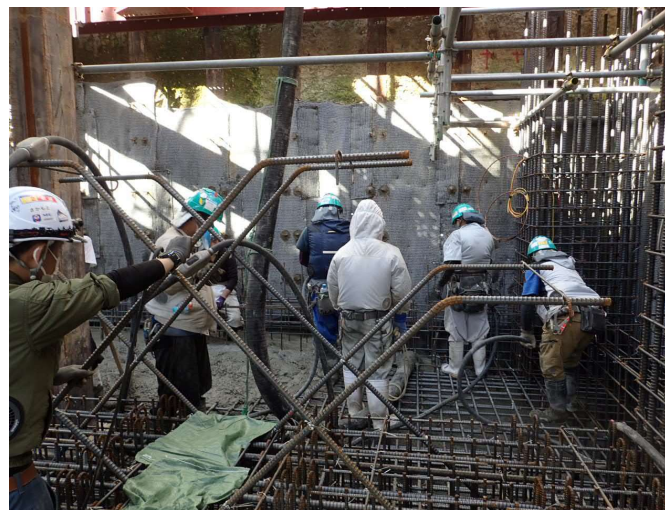
コンクリート打設工事
