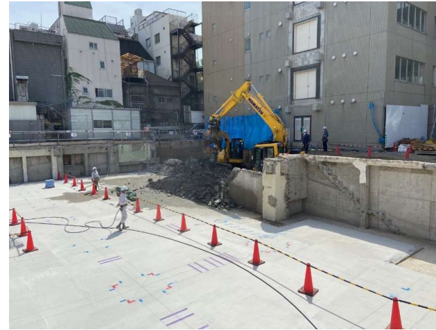
3号館既存壁解体
