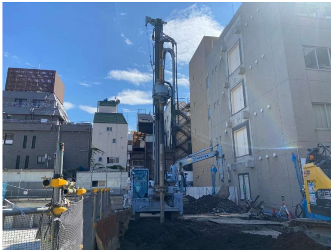
3号館地盤改良
