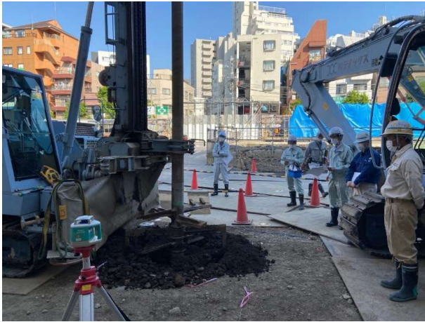
地盤改良試験杭
