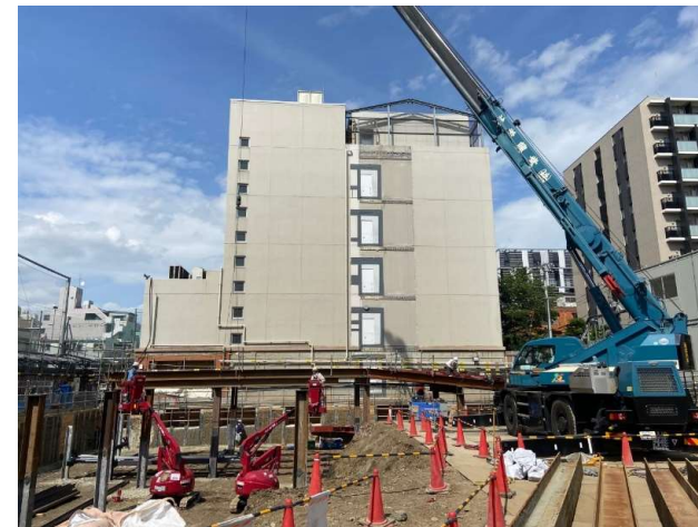
興風館構台架設工事
