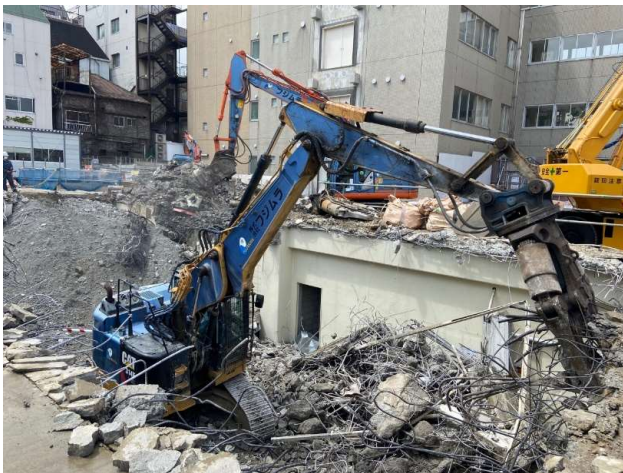
3号館床解体工事
