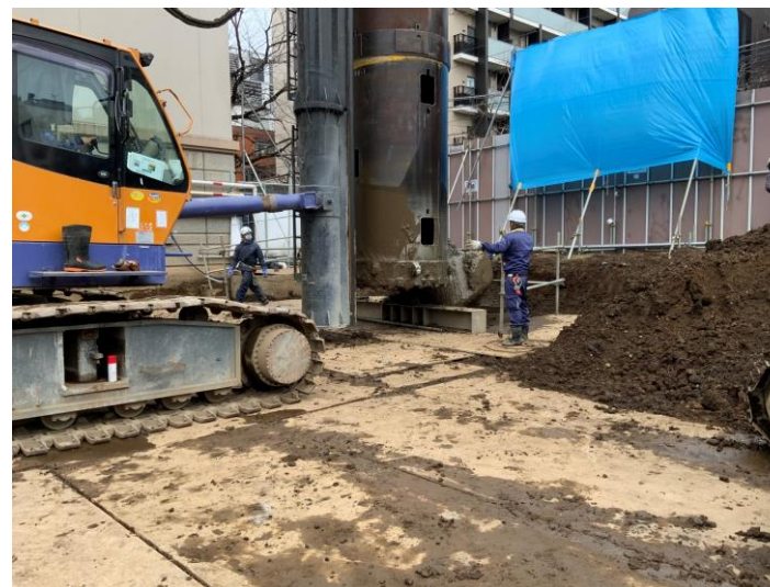
興風館杭抜き
