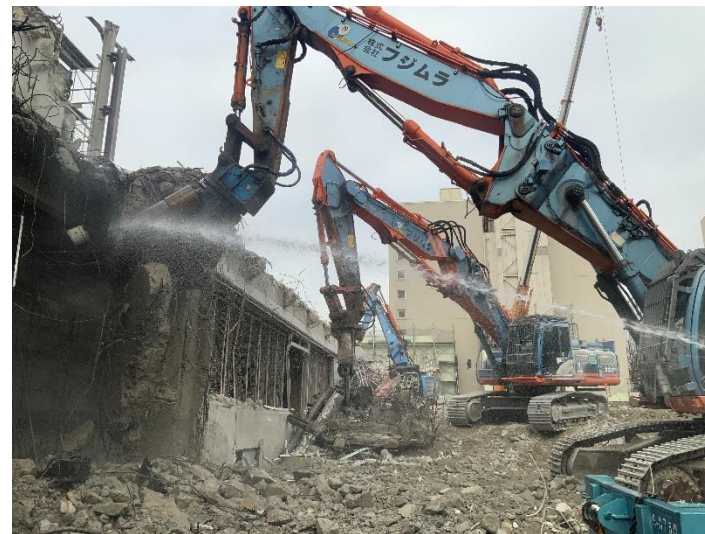
興風館1F躯体解体
