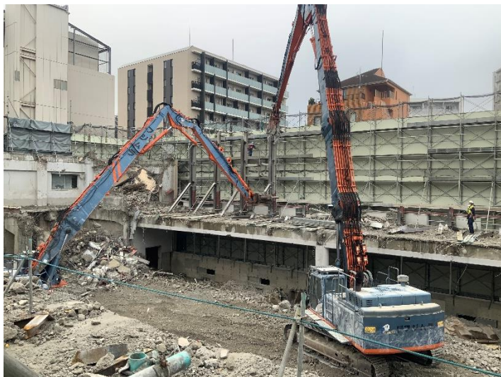
興風館2F躯体解体
