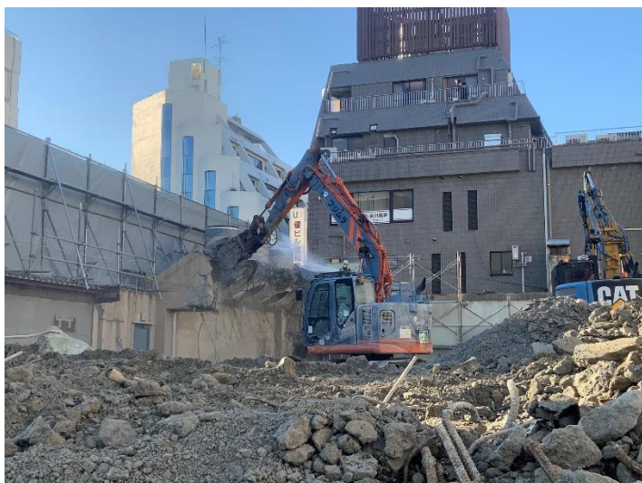
3号館1F躯体解体
